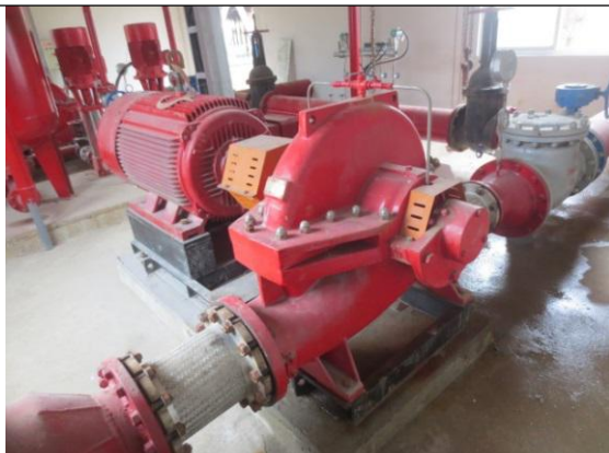
水泵减震基座
