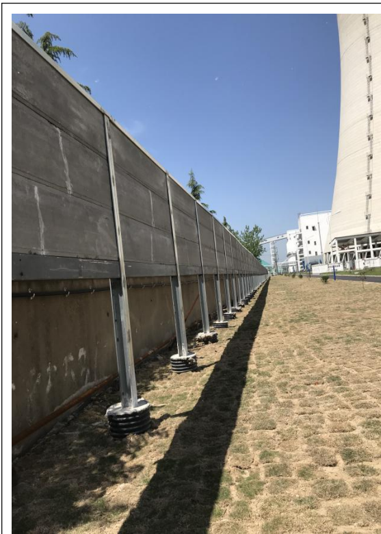
厂区南侧围墙（冷却塔）
