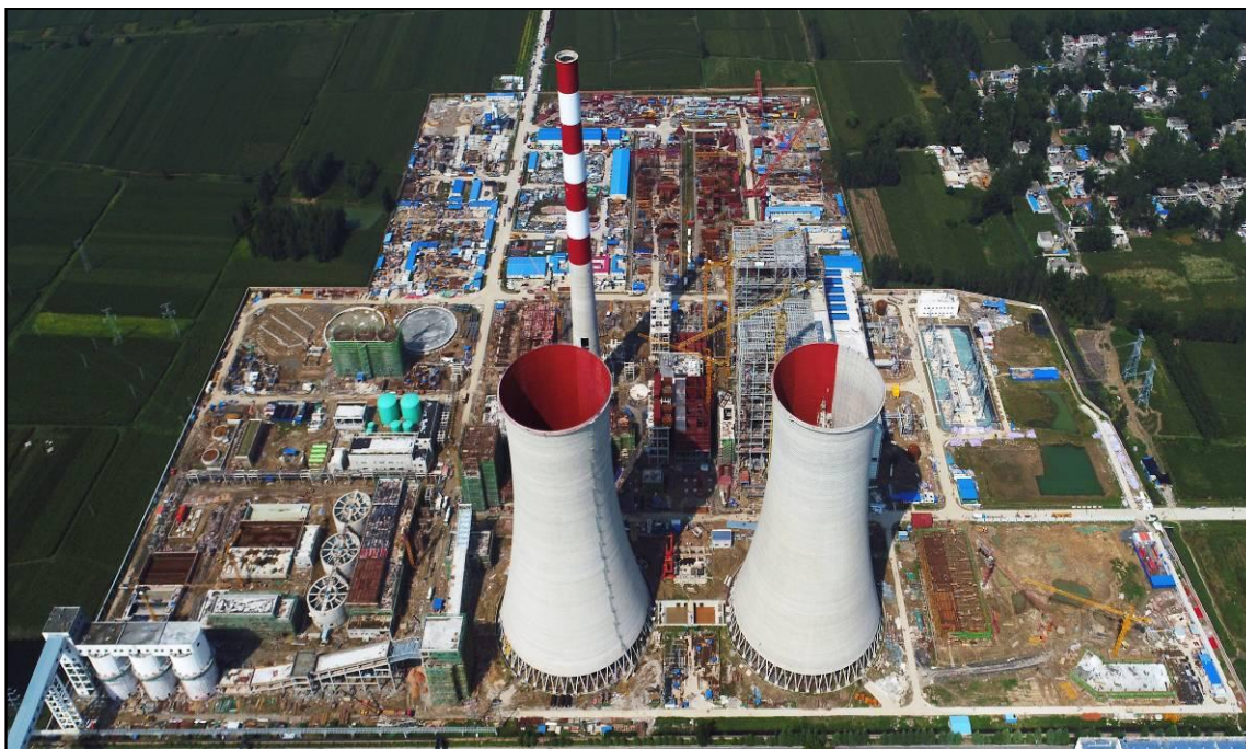
照片 1.14 工程建设进度概况（2017 年 9 月 11 日）
