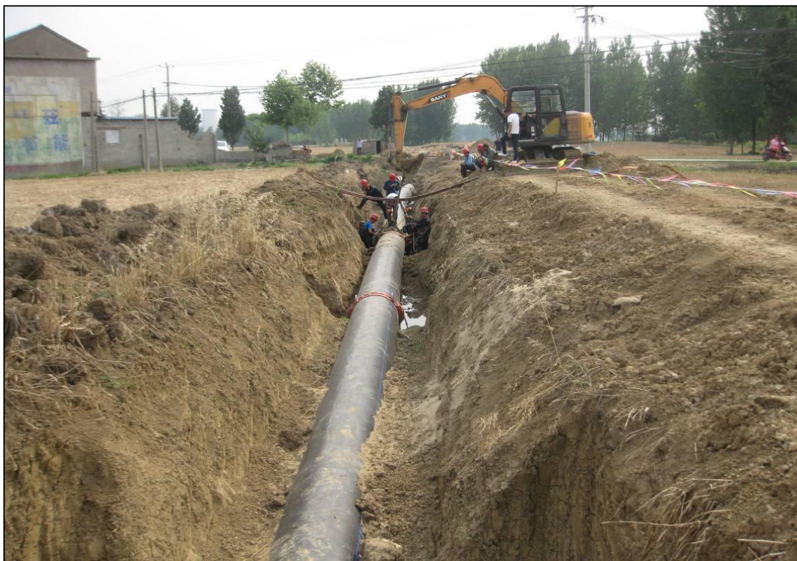
照片 1.7 供水管线施工
