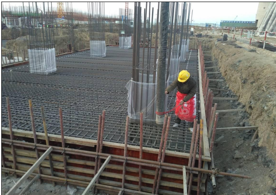
照片 1.5 主厂房施工
