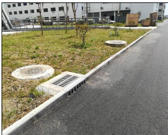
照片 2.7 厂内雨水井
