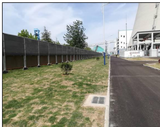
照片 2.10 场内排水设施
