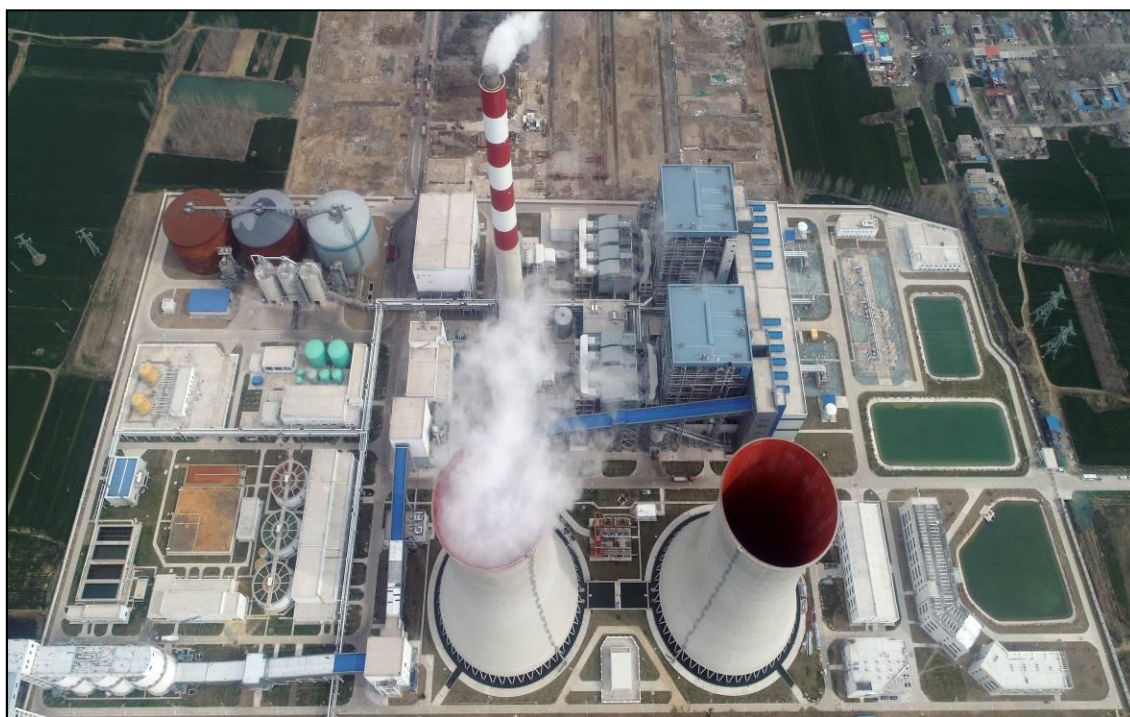
照片 1.19 工程建设进度概况（2019 年 3 月 26 日）
