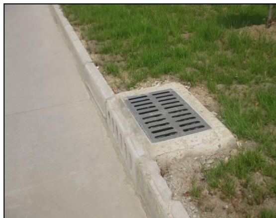
照片 2.8 厂区雨水口
