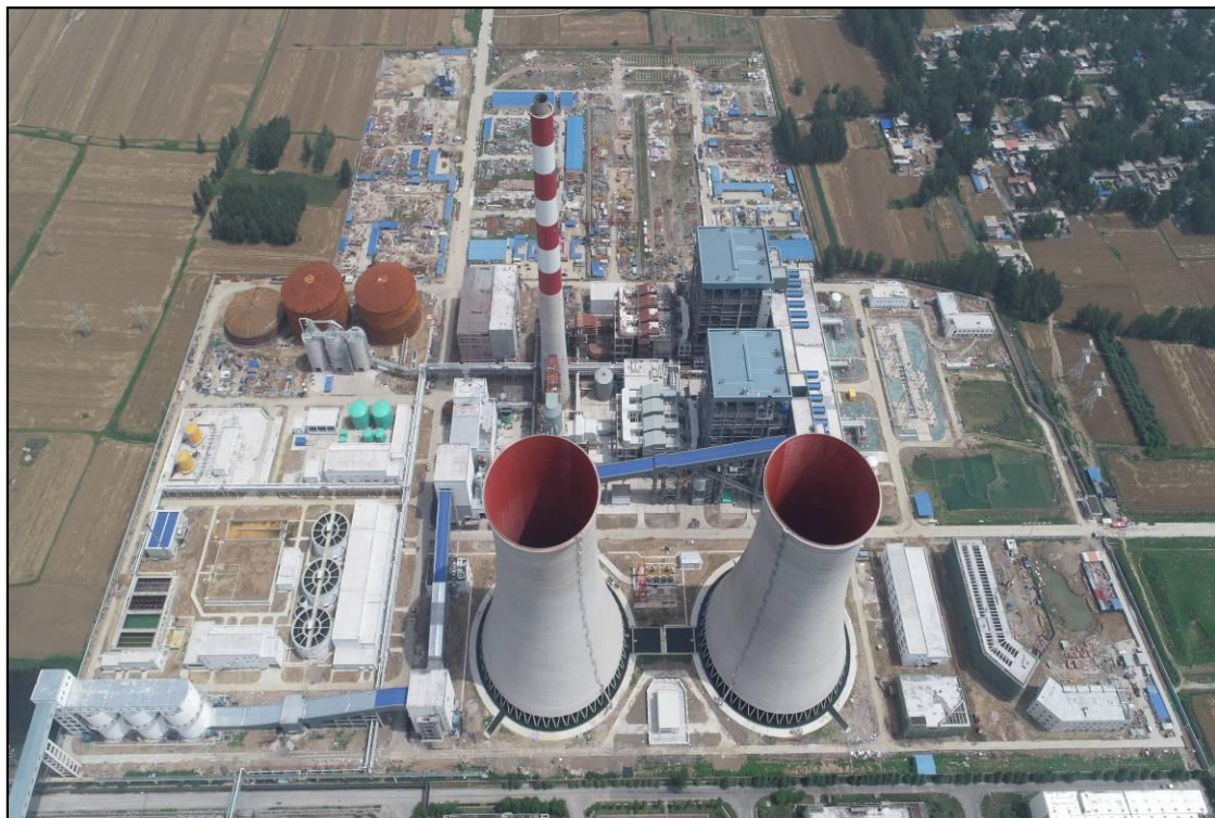
照片 1.18 工程建设进度概况（2018 年 5 月 28 日）
