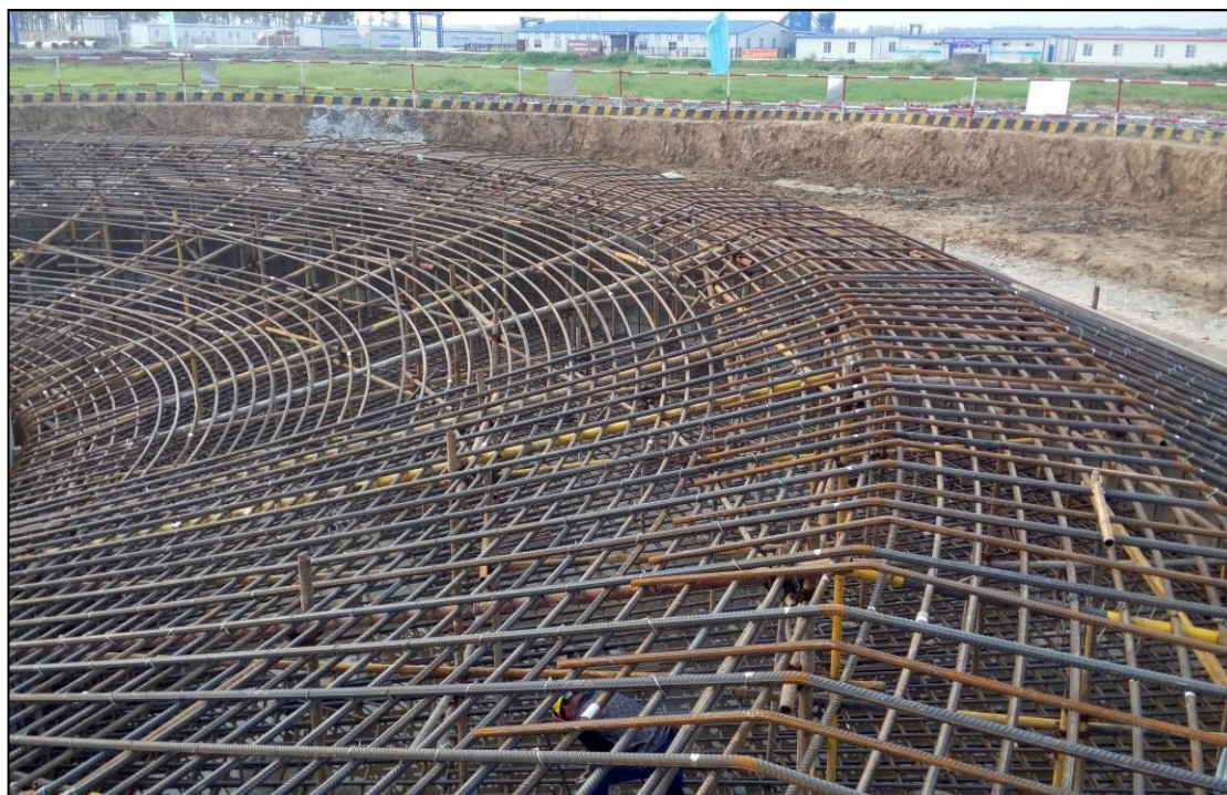
照片 1.2 冷却塔基础施工
