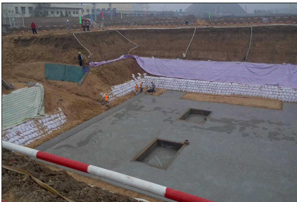
照片 1.6 主厂房基础施工
