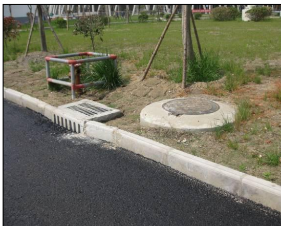
照片 2.9 厂内排水设施
