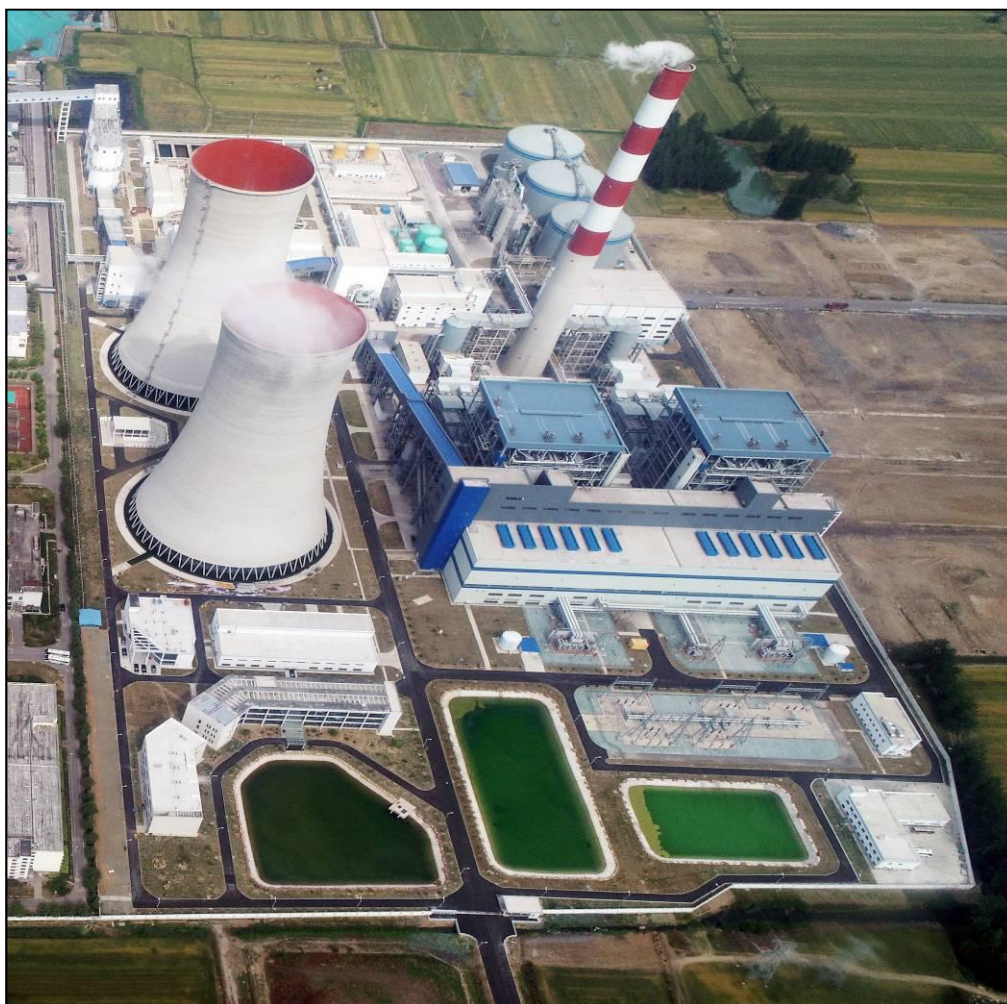
照片 1.20 工程建设进度概况（2019 年 5 月 20 日）
