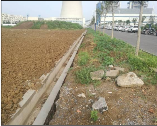
照片 2.11 进场道路排水沟
