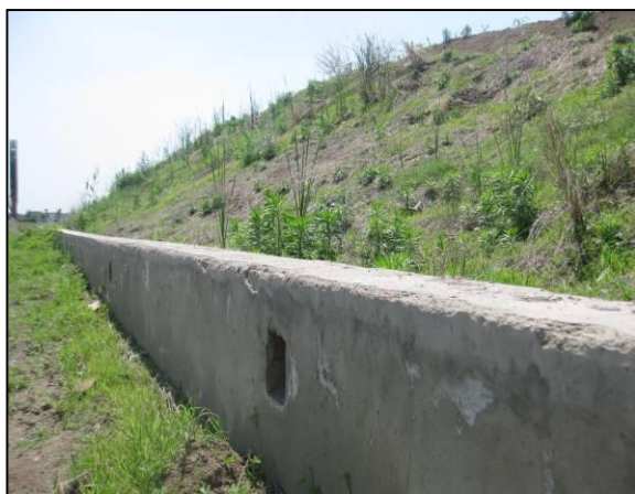
照片 2.29 堆土区浆砌砖挡土墙
