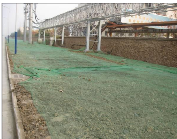
照片 2.29 堆土区浆砌砖挡土墙
