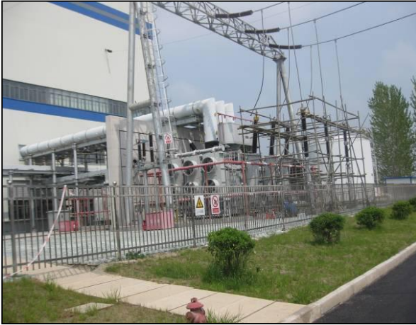
照片 2.19 升压站绿化
