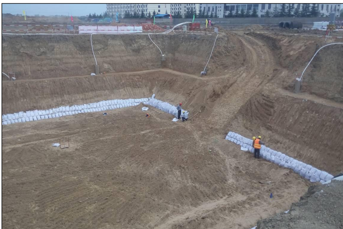
照片 1.4 主厂房基础开挖
