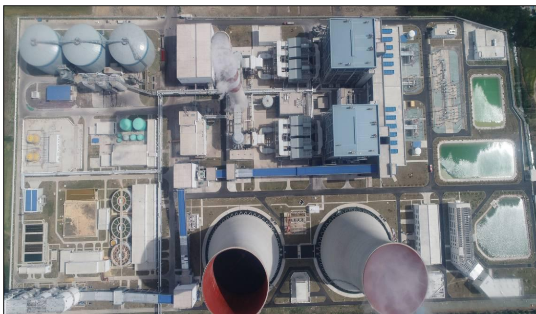
照片 1.21 工程建设进度概况（2019 年 5 月 20 日）
