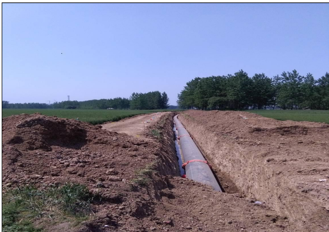
照片 1.8 供水管线施工
