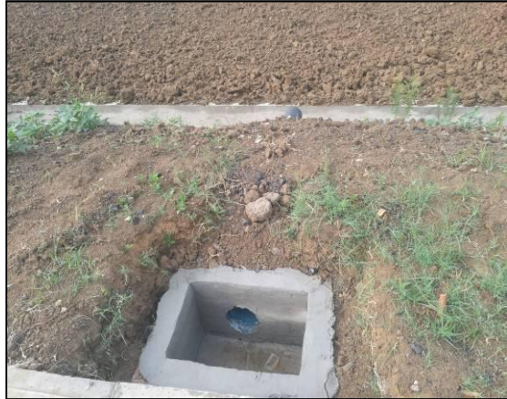
照片 2.12 进厂道路沉砂池
