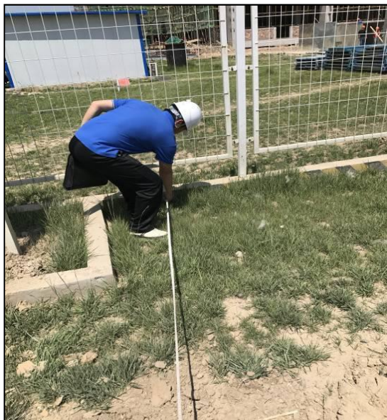
照片 1.11 临时措施面积测量
