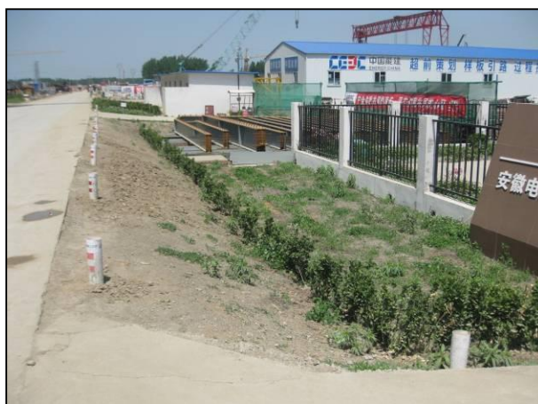
照片 2.28 施工生产区临时绿化措施
