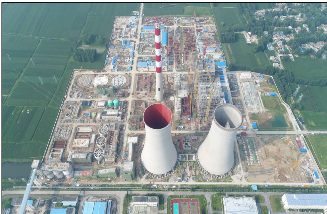
照片 1.13 工程建设进度概况（2017 年 8 月 15 日）
