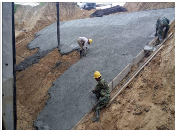
照片 2.26 基础开挖边坡防护
