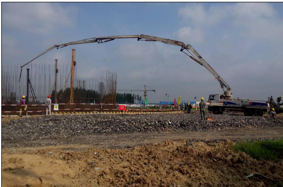
照片 1.3 主厂房基础浇筑
